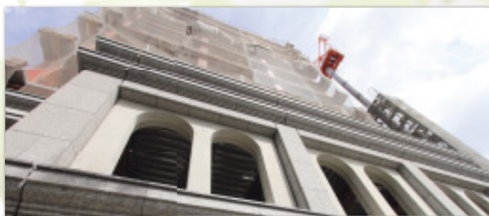
低層PC取付状況
