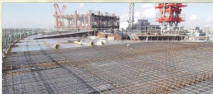
新1号館RF配筋状況
