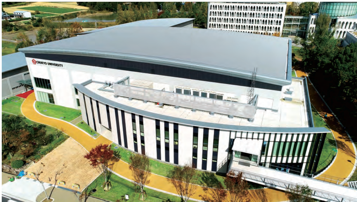
大体育館(3号館)
