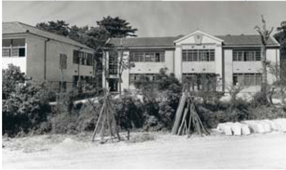
▲完成した記念館(5号館=右)と2号館(左)1955年
