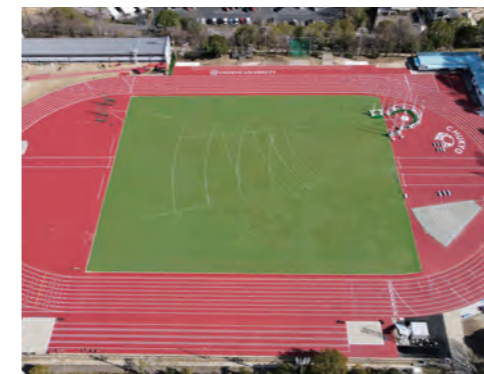
100周年記念事業の改修工事により、走路の状態が大幅に改善された中京大学梅村陸上競技場
